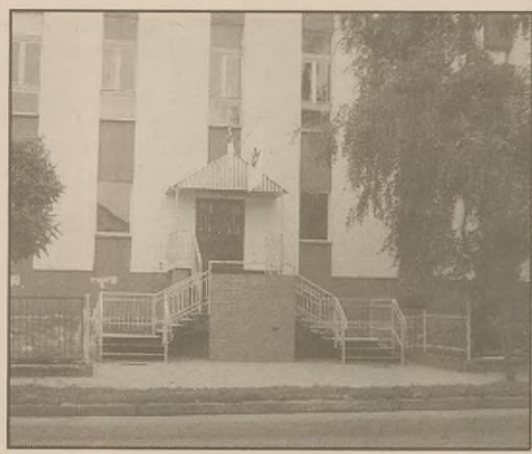
Od wtorku 15 lipca czynne jest już wejście do budynku telekomunikacji w Żninie od strony ul. Mickiewicza. Za drzwiami wejściowymi, po prawej stronie znajduje się biuro obsługi klienta, gdzie abonenci między innymi placą rachunki za telefon. Obwarowanie tego wejścia spowoduje zamknięcie dotychczasowego wejścia dla klientów wiodącego przez podwórkę telekomunikacji fot. Sławomir Kujawa
