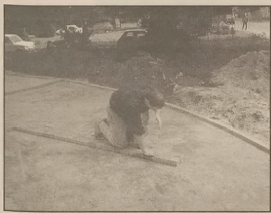
Zakładanie kostki betonowej przy kościele św. Floriana fot. Dorota Dzięczek
