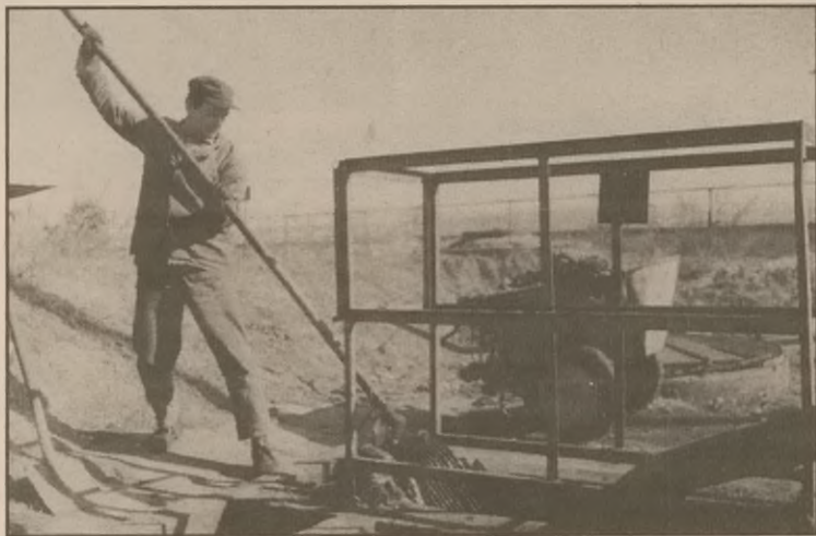
Pracownik na punkcie zlewnym wybierający - niestety ręcznie - ścieki stałe, które znalazły się w ściekach dowożonych przez beczkowozów. fot. Paweł Dobies
