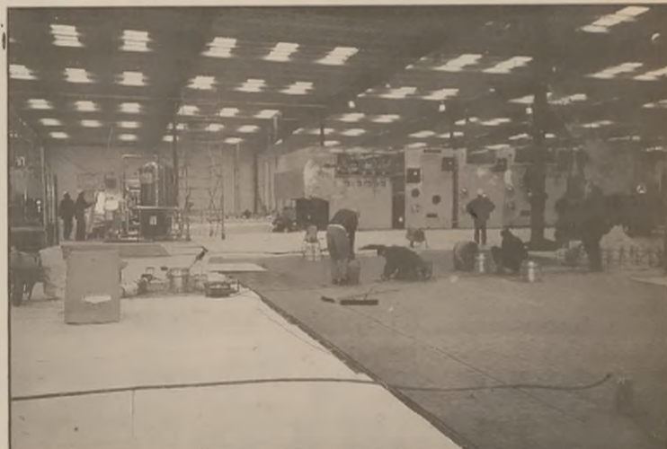
Stoją już pierwsze maszyny. Na pierwszym planie układanie płytek, w głębi - po lewej mixprocessor (maszyna do rozcieńczania ługu sodowego), po prawej - myjka do mycia butelek. fot. Paweł Dobies
