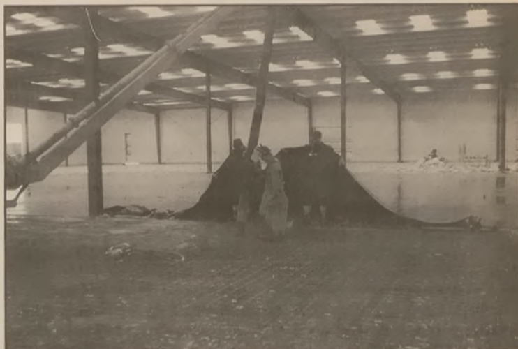
Zalanie posadzki maszyną z wysięgnikiem podającym beton. fot. Paweł Dobies
