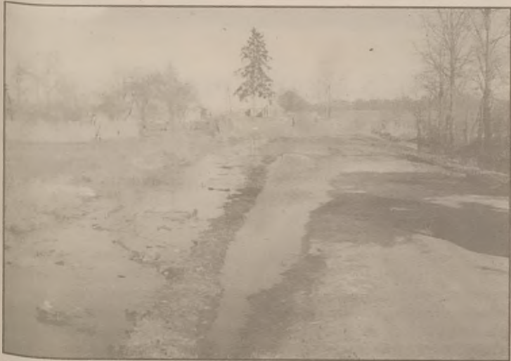
Przelewająca się przez szosę woda roztopowa z pól zalewająca gospodarstwo Franciszka Kubisztala z Grocholina k. Kcyni. Widoczna też stojąca w rowie przydrożnym nie mająca odpływu do Kcyni. Rów zarośnięty.
