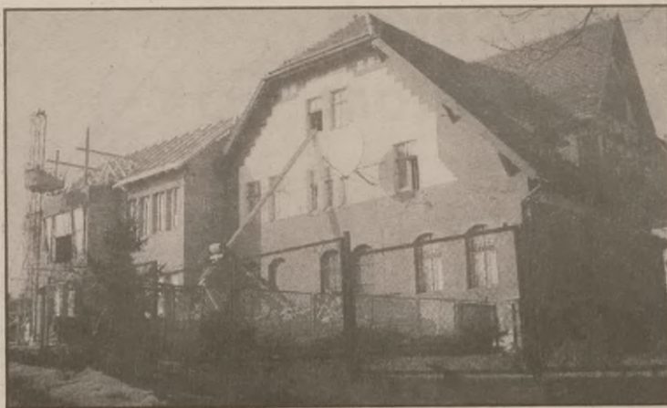
Bank Gdański w trakcie rozbudowy
