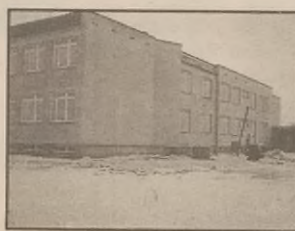
Żnińska Szkoła Podstawowa nr 5 w budowie. fol. Dominik Księski
