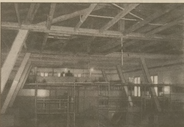
Gąsawska Stodola przechodzi gruntowny remont z uwagi na nowe przepisy bezpieczeństwa i przeciwpożarowe. Termin zakończenia robót został wyznaczony na najbliższy bal sylwestrowy. fot. Jacek Mielczarewicz
