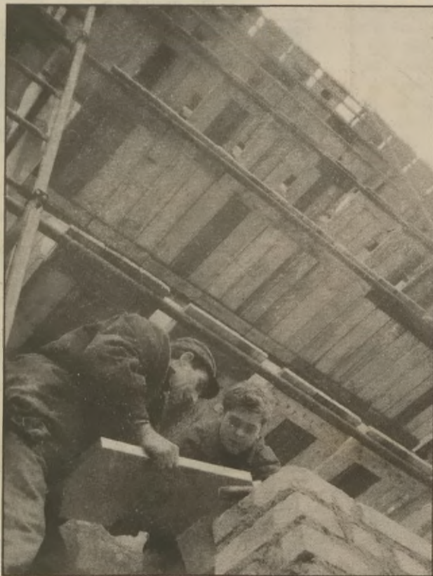
"I coraz większa trwa budowa..."
