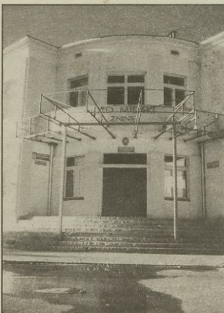
Jak powiedział autor niniejszego zdjęcia: " - Wizja, która ma zmaterializować się w postaci "zadaszenia" jest szpetna i psuje autorskie dzieło Zygmunta Schmidta". Przed Urzędem Miejskim widoczna plama wody z pękniętej pod ziemią rury. W ostatnią niedzielę były tam spod asfaltu hoże źródelka.
