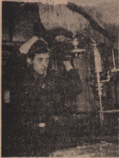
Młodzież Nowej Huty radośnie przyjęła apel Zarządu Głównego ZMP w sprawie Złota w Warszawie Młodych Przemysłowców — Budowniczych Polski Ludowej. Na zdjęciu: ZMP-owiec Tadeusz Styczek przy wierceniu otworów w konstrukcji stalowej osiąga 240 proc. normy. (Foto — CAF)
