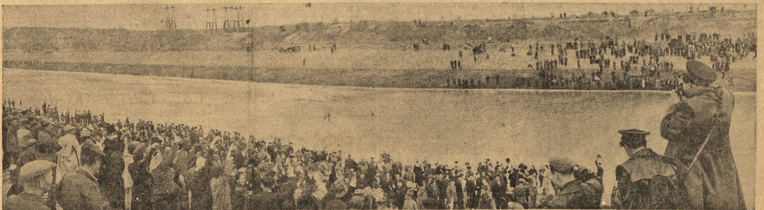
Historyczny moment. Spotkały się wody dwóch wielkich rzek — Wołgi i Donu. Budowniczowie Kanału oraz mieszkańcy Stalingradu i okolicznych kolchozów radośnie witają połączenie rzek.
