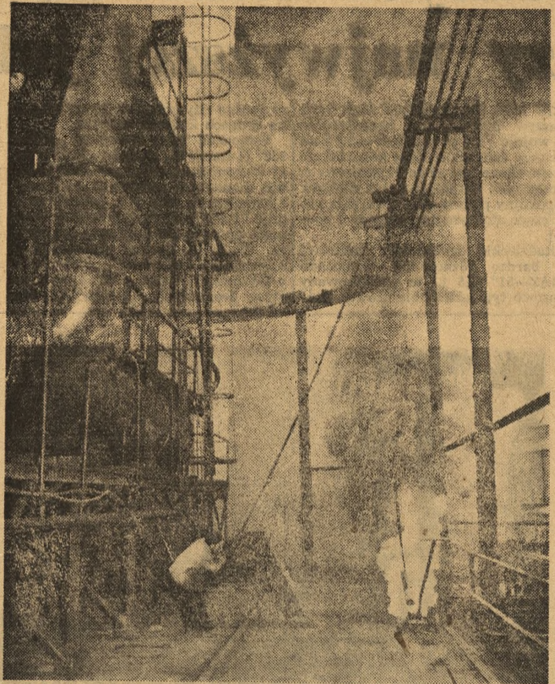
W maju została uruchomiona na terenie huty „Kościszko” nowa bateria koksownicza, którą budowali robotnicy polscy i czescy. Po okresie próbnym, obecnie bateria przeszła na planową produkcję. NA ZDJĘCIU: Po obsadzeniu komory koksowniczej węglem — Maksymilian Neuman dzwigniem wyciąga farcę z komory koksowniczej. Foto CAF — Jerzy Baranowski
