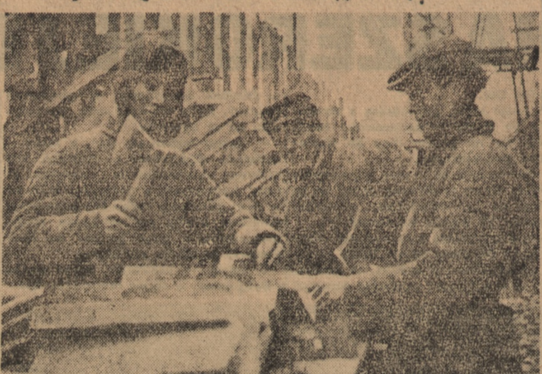
...głosi art. 14 projektu nowej Konstytucji. Tak pojmuje pracę również wyróżniająca się przy budowie dalszych hal Fabryki Samochodów Ciężarowych w Lublinie brigada cieśli Luźwika Kołczona, osiągająca 220 procent normy. Od lewej: cieśla — przodownik pracy Wacław Barczak. (Foto CAF)
