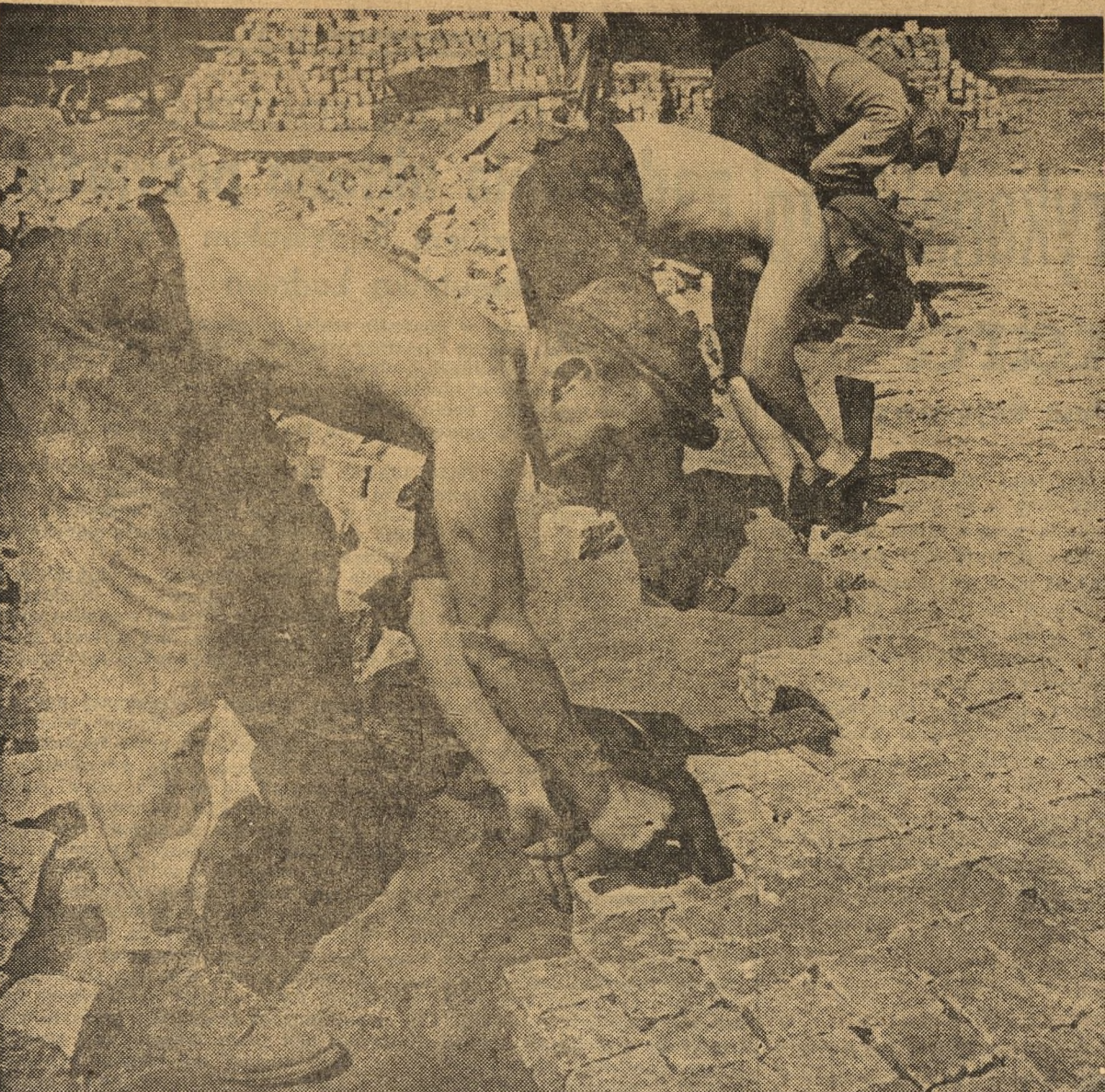
Praca jest prawem, obowiązkiem i sprawą honoru każdego obywatela NA ZDJĘCIU: Robotnicy brukarscy przy zakładaniu nowej nawierzchni jednej z ulic Bydgoszczy.
