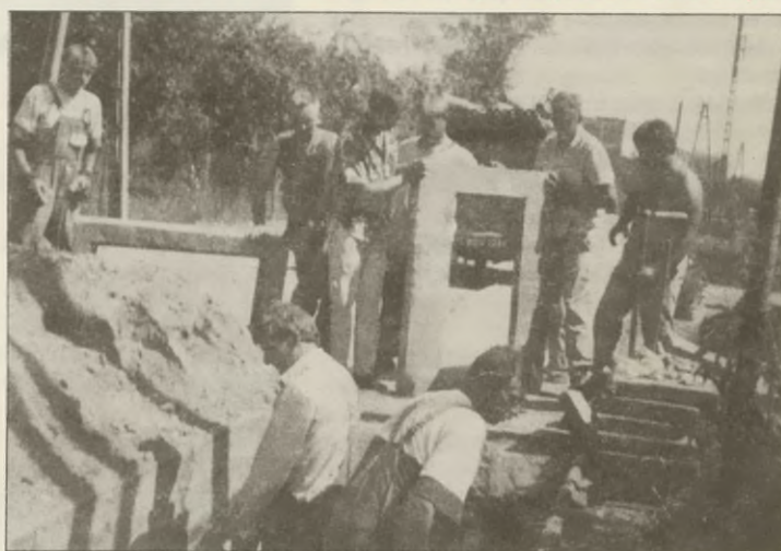
Prace przy studzience telekomunikacyjnej
