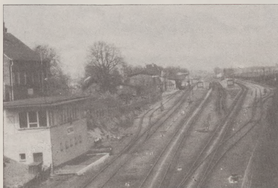
Widok z wiaduktu na najważniejszy węzeł kolejowy Pałuk
