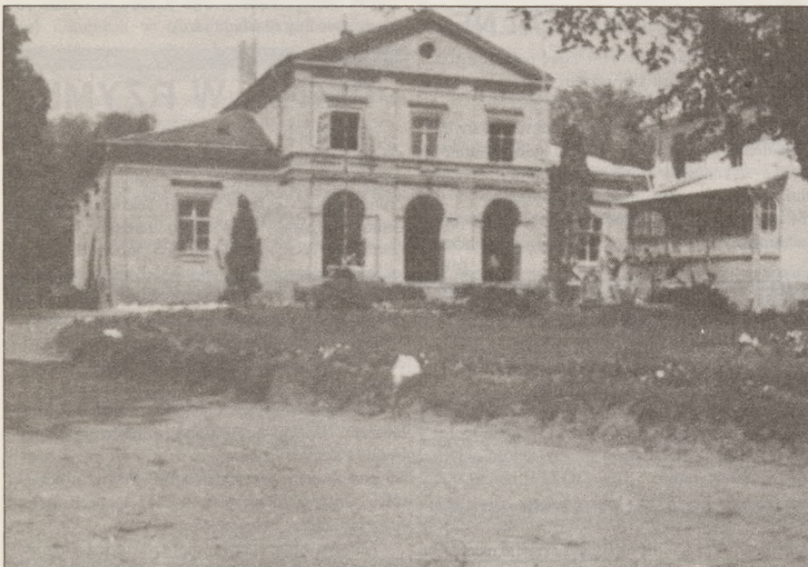
Budynek Domu Pomocy Społecznej przed przebudową (1962 rok)
