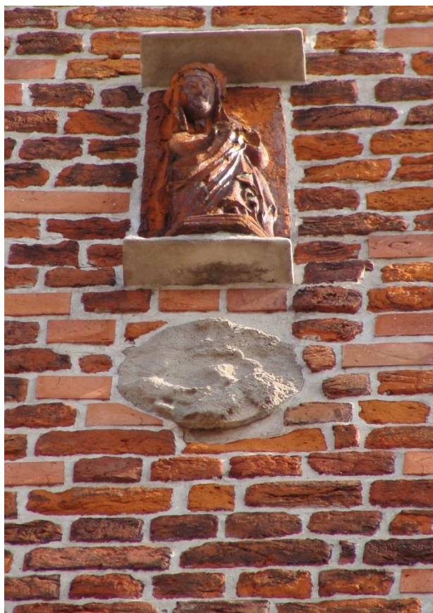
Ściana zachodnia wieży. Matka Boska, fragment tympanonu w ścianie z wiązaniem pospolitym. Fot. W. Orzepowski, [Wrocław], 2008 r.
