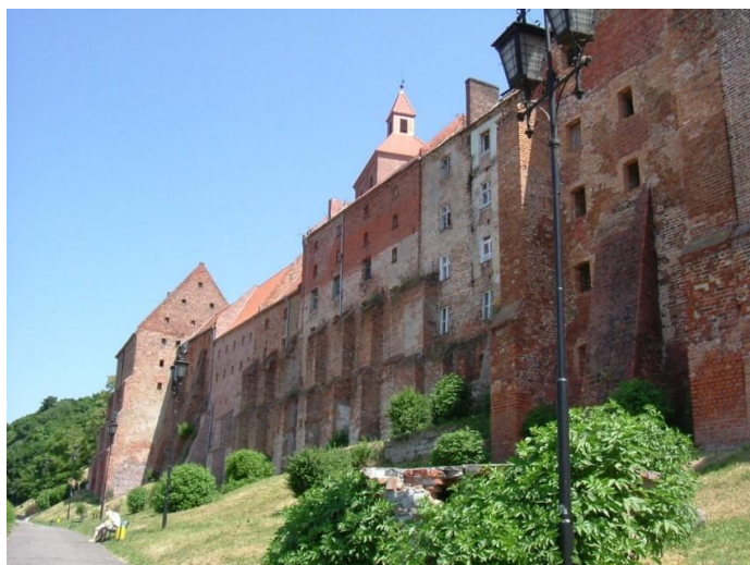
Obiekt przy. Ul. Spichrzowej 37-47.
