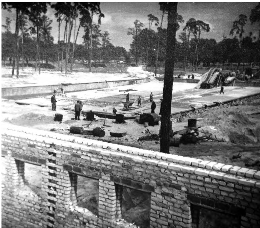
Niecka basenu w końcowej fazie budowy.
