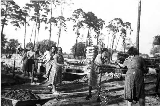
Mieszkańcy Bydgoszczy pomagali przy budowie kąpieliska.
