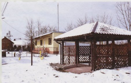
Świetlica wiejska w Szczytnikach
