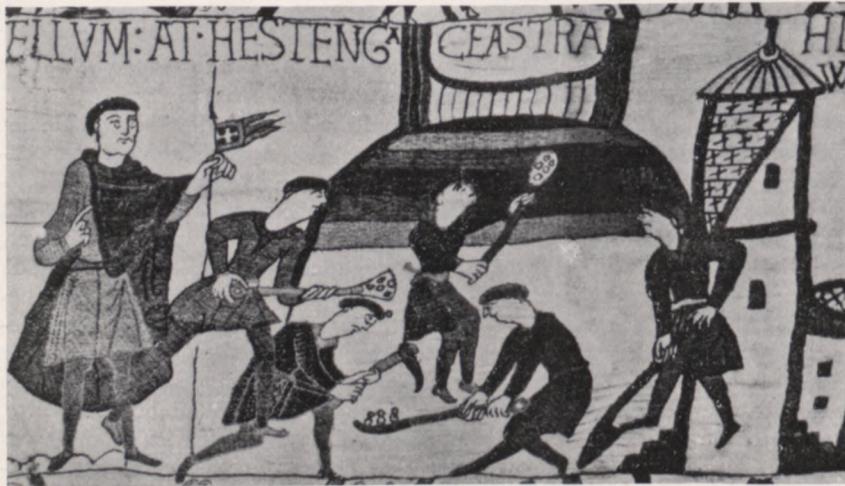
32. Burgbau Wilhelms bei Hastings. Ausschnitt aus dem Teppich von Bayeux. 'Iussit ut foderetur castellum at Hesteng'. Ein Graben wird ausgehoben, das gewonnene Erdreich zu einem Hügel aufgehäuft und festgestampft; der schon bereit gehaltene hölzerne Turm soll dann auf der Höhe innerhalb der Einpfählung, wo das Wort ceastra zu lesen ist, aufgestellt werden.
