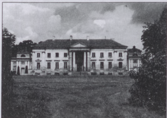
1. Elewacja frontowa pałacu
