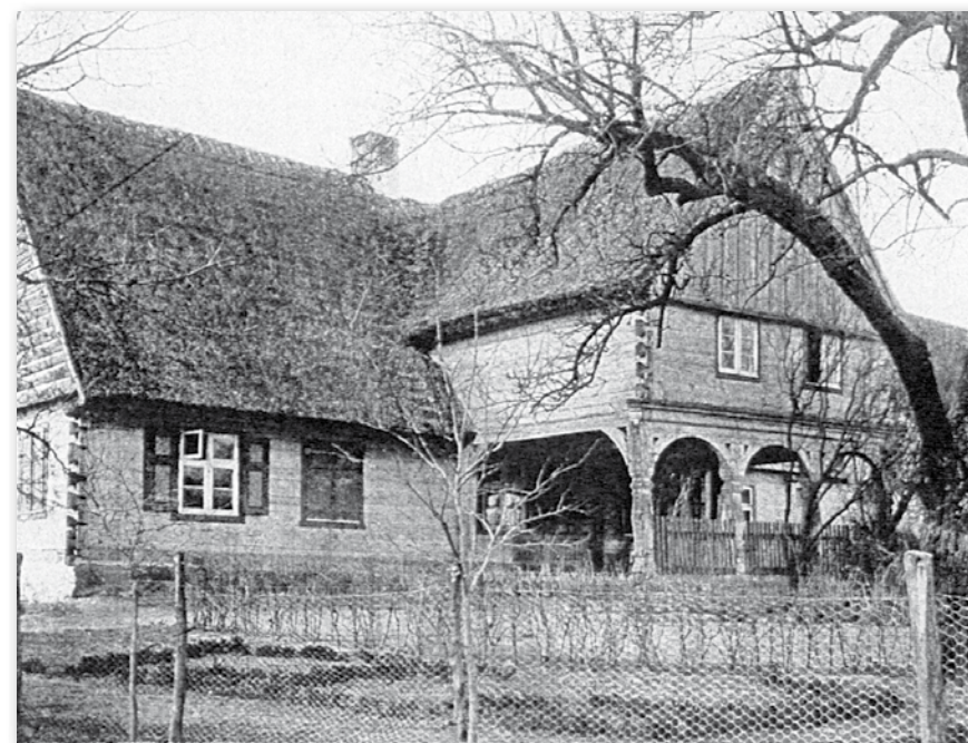
Il. 6. Zagroda Kaniczki 21 z 1757 r. Budynek z podcieniową wystawką mieszczący pod jednym dachem część mieszkalną i inwentarską (H. Wernicke, op. cit., Abb. 2).
