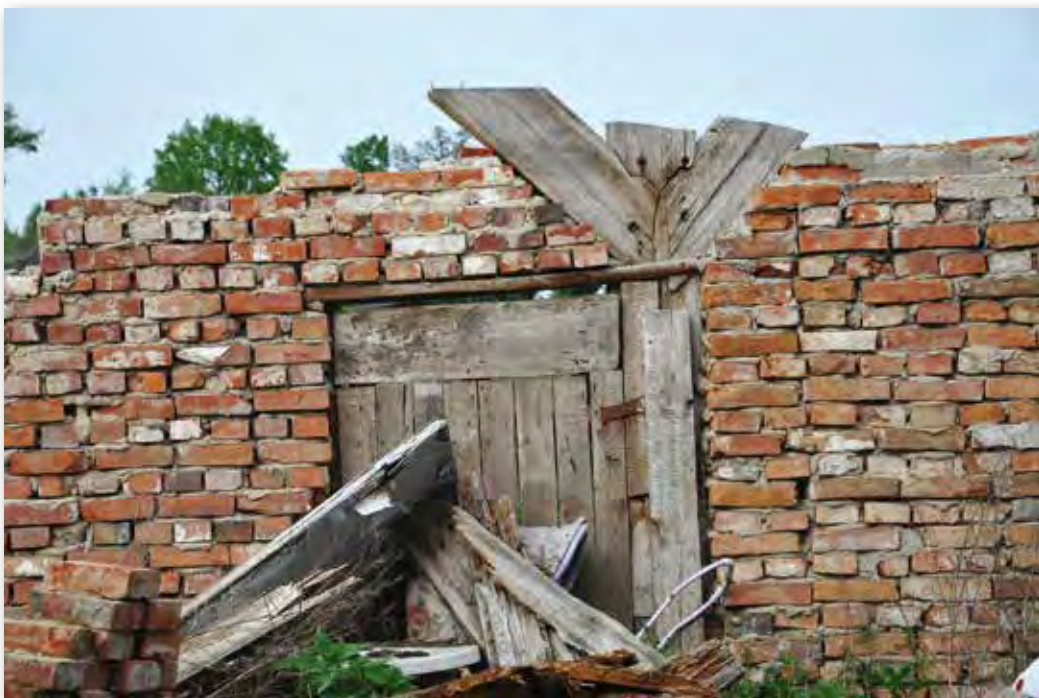
Il. 8. Zagroda Kaniczki 21 z 1757 r. Ściana szczytowa obory z zachowanym słupem stanowiącym pierwotnie część konstrukcji szkieletowej stodoły (fot. M. Prarat, 2010)
