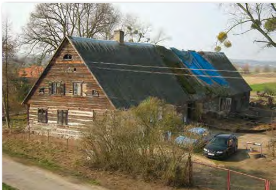
Il. 2. Zagroda Niedźwiedź 4 z końca XVIII w. Jedyne zachowany budynek w pasie nadwiślańskim posiadający część mieszkalną, inwentarską i stodołę pod jednym dachem, wszystkie w konstrukcji wieńcowej (fot. M. Prarat, 2009)
