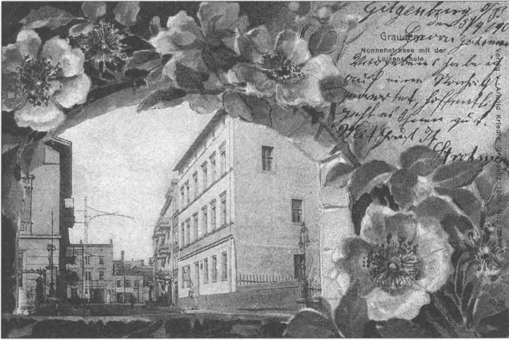
Il. 1. Ulica Nonnenstrasse (obecnie ul. Klasztorna) w Grudziądzu. W kamienicy narożnej (nr 5) na parterze znajdowała się pierwsza siedziba grudziądzkiego Muzeum Miejskiego (do 1893 r.). Zbiory Działu Historii, MG/IK/4936; dar Janiny Zawadzkiej
