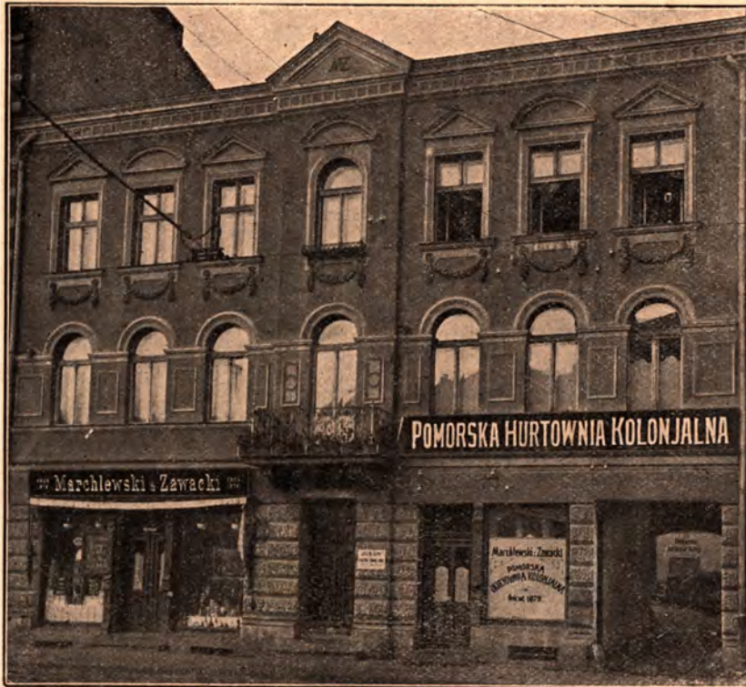
Elewacja frontowa własnego gmachu firmy Marchlewski i Zawacki w Grudziądzu, przy ul. Józefa Wybickiego nr. 29.
