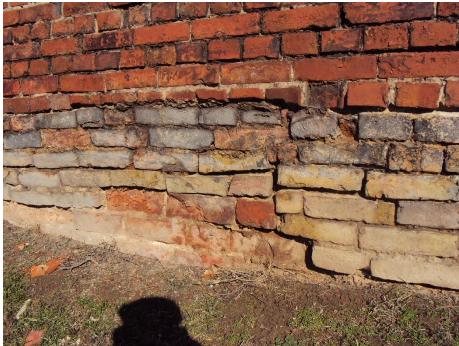
9. Mur obronny, południowy. Cegła romańska niedopalka w przyziemiu. Następne partie z przełomu XIII/XIV w.
