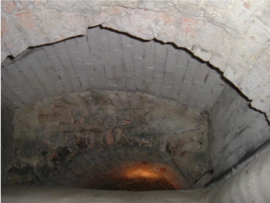
2. ul. Kościelna 10. Dawne stajnie kościelne. Romańskie sklepienie kolebkowe.
