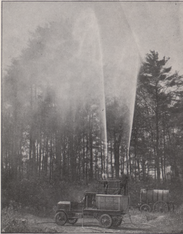
Fig. 219. Motorspritze (auf Automobil) mit zwei Schläuchen. (Phot. Fitzhenry-Guption.) Aus Escherich.
