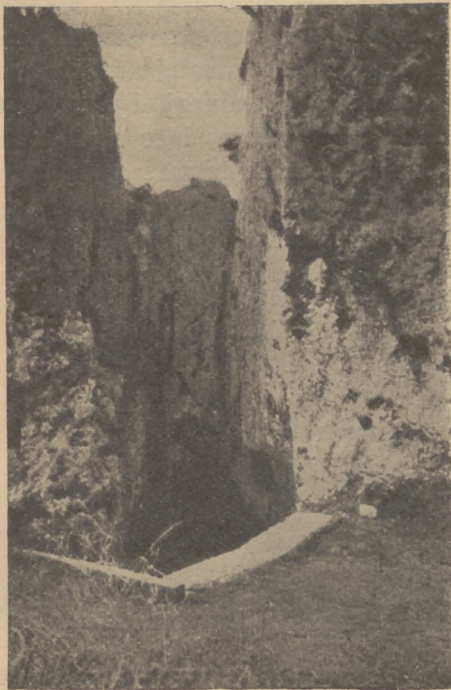
41. Kanał odwadniają- jący bagna koło Bu- rano tzw. Tagliata di Ansedonia.
