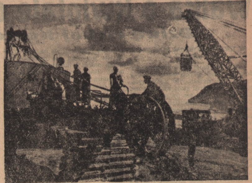
Budowa hydrowężła w Kujbyszewie. Montowanie kopaczki elektrycznej w Żygulewskim rejonie budowy hydrowężła Kujbyszewskiego
