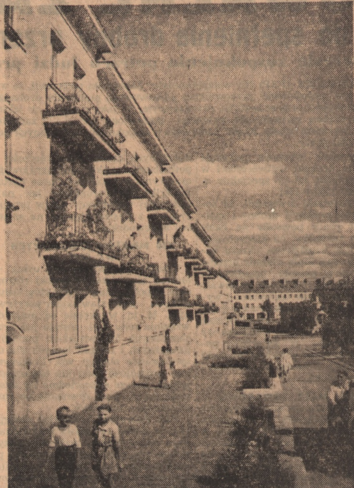
W wielkim dziele budowy nowej socjalistycznej Warszawy, niemały jest udział rzemieślników. Murarze, szklarze, instalatorzy, elektrotechnicy, wyrosli przy warsztacie rzemieślniczym, swoją codzienną pracą na budowach stolicy, wraz z całym narodem, kładą fundamenty szczęśliwego pokojowego jutra Polski. (Foto — CAF)
