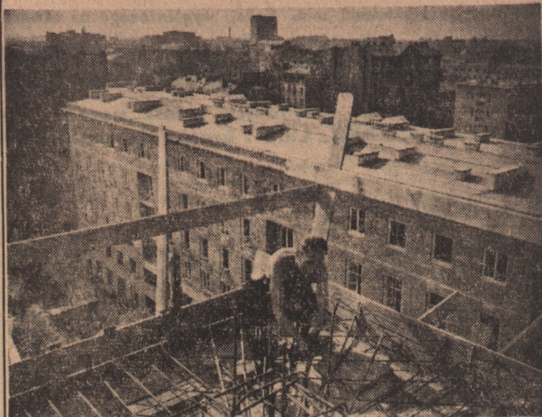
Budowa Marszałkowskiej Dzielnicy Mieszkaniowej. Na zdjęciu: Zbrojarz — Henryk Józwiak wykonujący ponad 200 proc. normy przy pracy. Na dalszym planie blok 4a. (Foto — CAF)
