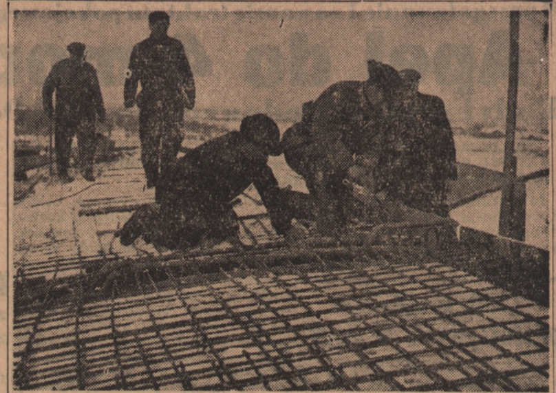
Jednym z gigantycznych osiągnięć Planu 6-letniego będzie wielki kombinat bawelnianny, który powstaje w Piotrkowie Trybunalskim pod Łodzią. Nawet śnieg i mrozy nie potrafią zahamować szybkiego tempa budowy. Na zdjęciu grupa betoniarzy, która osiąga normalnie 170 proc. normy, układa wiązania pod strop betonowego dachu jednej z hal fabrycznych. Foto — Film Polski
