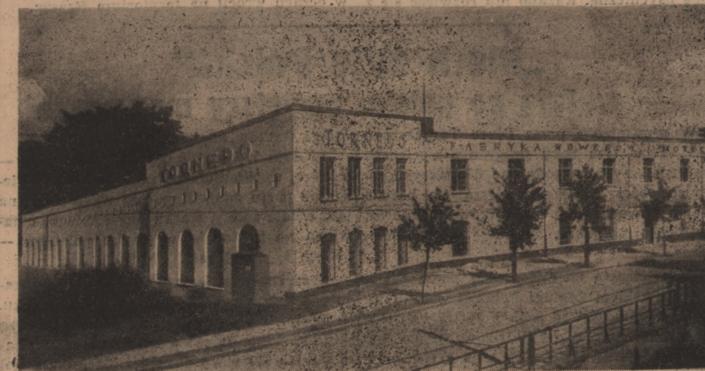
Zakłady fabryczne fabryki rowerów i motocykli „Tornado” w Bydgoszczy przy ulicy św. Trójcy nr 34.
