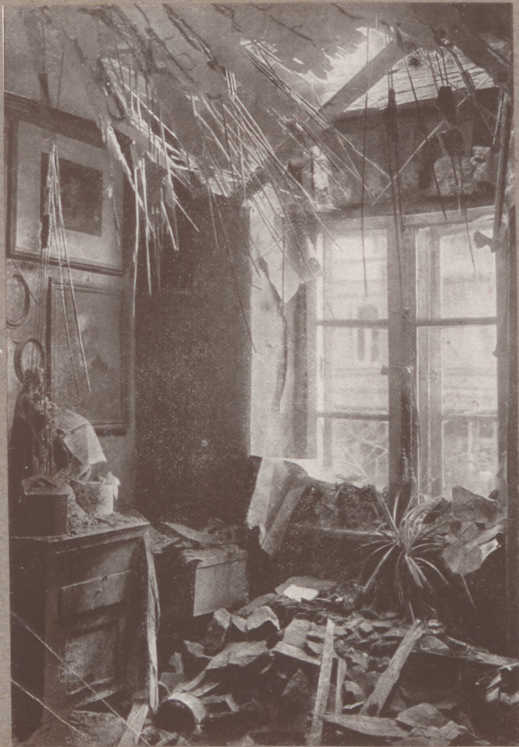
WNĘTRZE DOMU NA ULICY CHŁODNEJ W WARSZAWIE, GDZIE SPADŁA BOMBA RZUCONA Z AEROPLANU NIEMIECKIEGO.
