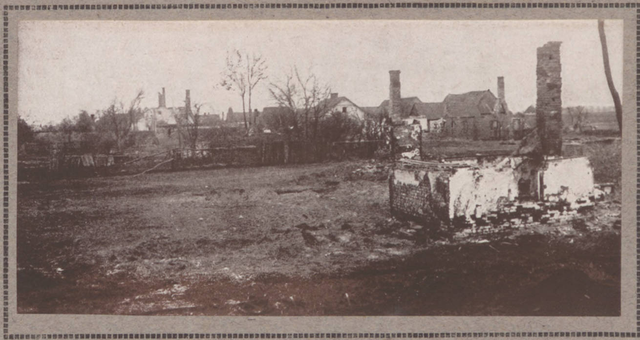
WIEŚ SOKOŁÓW POD ƔASZYNEM.
