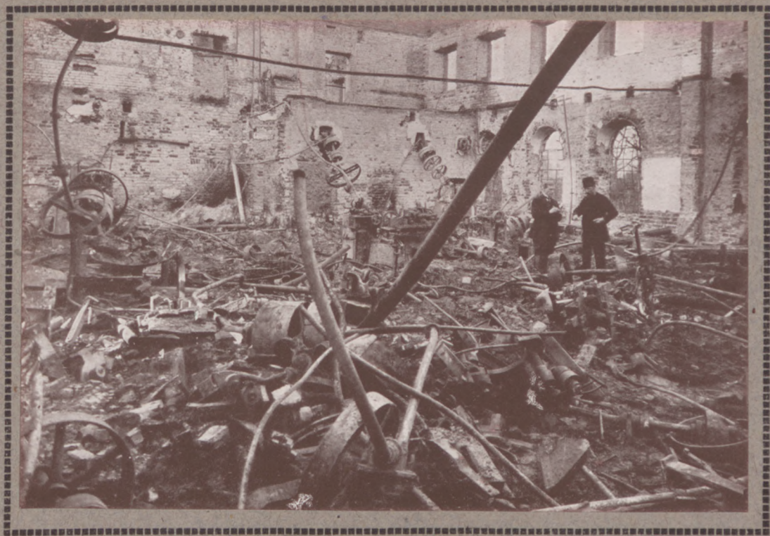
WNĘTRZE FABRYKI OŁÓWKÓW MAJEWSKIEGO W PRUSZKOWIE.
