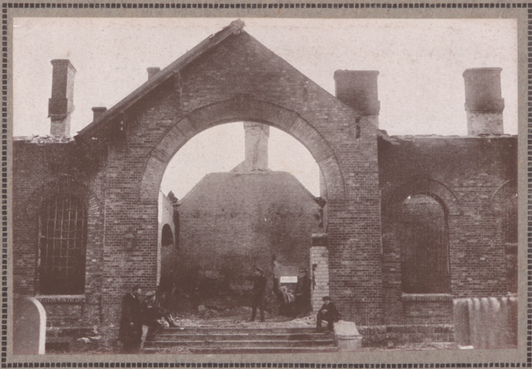
STACJA KOLEJOWA W ŁOWICZU.
