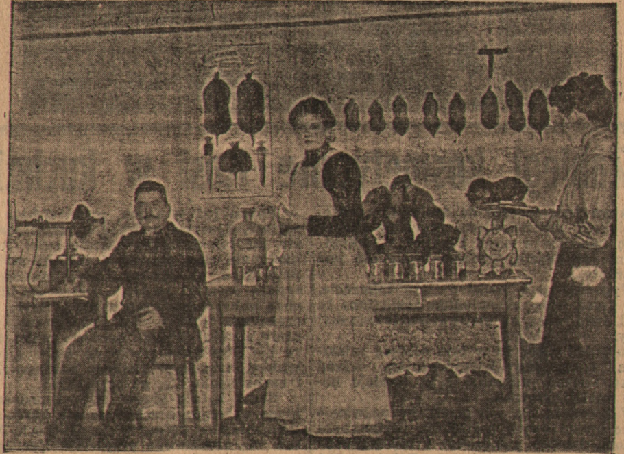
Fragment laboratorium selekcyjnego.
