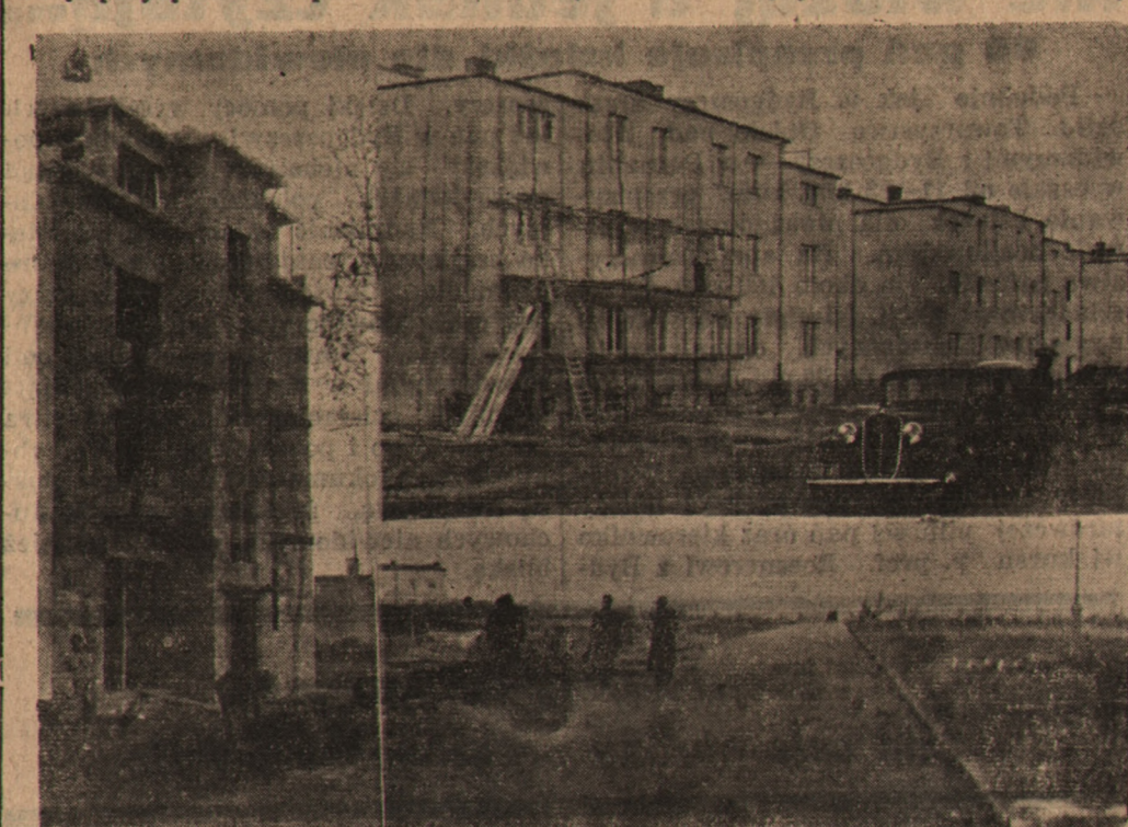
Dom 3-piętrowy, wyniesiony dopiero pod dach. U góry: Ulica w zabudowie. U dołu: Odcinek ulicy jeszcze nie zabudowanej.
