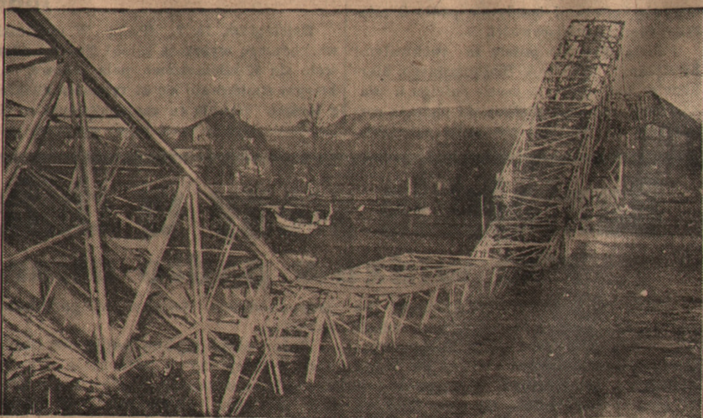
W pobliżu Bernburgu w Niemczech załamał się z nieustalonych jeszcze przyczyn kolejowy most o żelaznej konstrukcji, przez co uniemożliwiony został ruch statków na rzecę.
