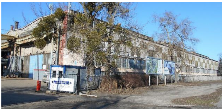
Ryc. 7. Jedna z hal na terenie Makrum – 2019 r.; hala została wyburzona na przełomie marca i kwietnia 2020 r. (fot. ze zbiorów autora)
