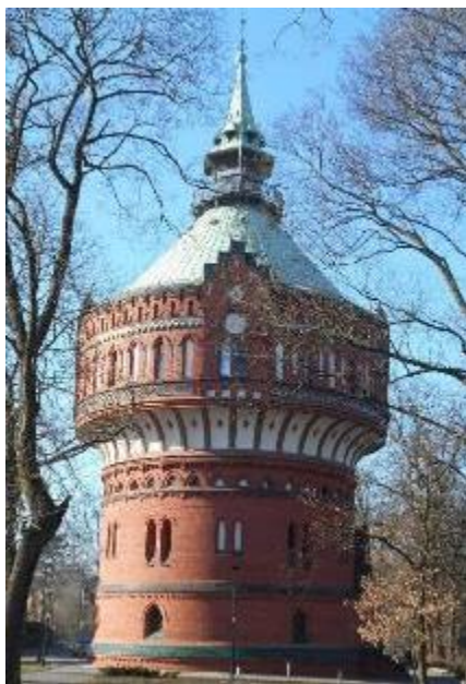
Ryc. 9. Wieża ciśnień przy ul. Filareckiej 1 – widok współczesny (fot. ze zbiorów autora)
