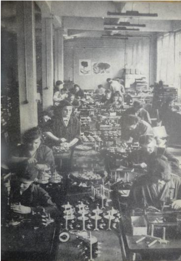
Ryc. 1. Taśma produkcyjna w Zakładach Radiowych Eltra w Bydgoszczy Źródło: Bydgoszcz. Wczoraj - Dziś - Jutro , Prezydium Miejskiej Rady Narodowej w Bydgoszczy, Bydgoszcz 1961, s. 19.
