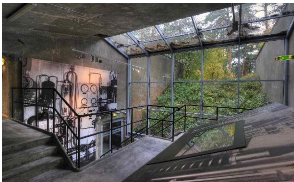
Ryc. 4. Budynek nitracji 1137 – służący do produkcji nitrogliceryny; ze względu na charakter produkcji i zagrożenie eksplozją, ale i w celu jego zamaskowania, został wkomponowany w piaszczyste zbocze, z jednoczesnym odsłonięciem frontu, gdzie znajdowała się tzw. ściana wydmuchowa (fot. ze zbiorów Wojciecha Woźniaka, MOB)
