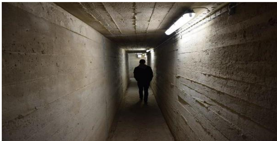
Ryc. 1. Tunel transportowy pomiędzy budynkami 1134–1133; tunele wykorzystywane w strefie produkcji nitrogliceryny pozwalały na ukrycie rurociągów produkcyjnych, a także zabezpieczały je przed skutkami nalotów bombowych (fot. ze zbiorów Wojciecha Woźniaka, MOB)
