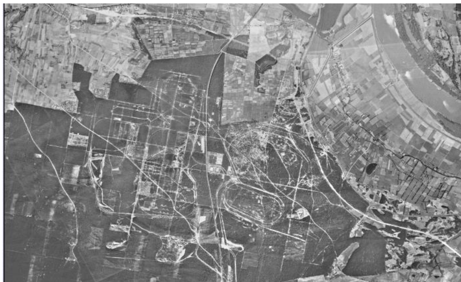
Ryc. 2. Kompilacja zdjęć lotniczych wykonanych w 1944 r. przez aliancki samolot – widoczny jest obszar fabryki, który wpisał się w gęstą Puszcze Bydgoską; przez środek fabryki przebiega linia kolejowa, tzw. magistrala węglowa, dzieląc DAG Bromberg na dwie części: zachodnią – DAG Kaltwasser oraz wschodnią – DAG Brahnau Źródło: Luftbilddatenbank Estenfeld.
