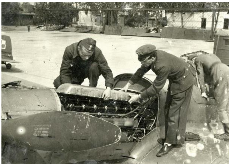
Ryc. 11. Przegląd silnika samolotu Ił-2M/3 na bydgoskim lotnisku, 1947/1948 r. (fot. ze zbiorów autora)
