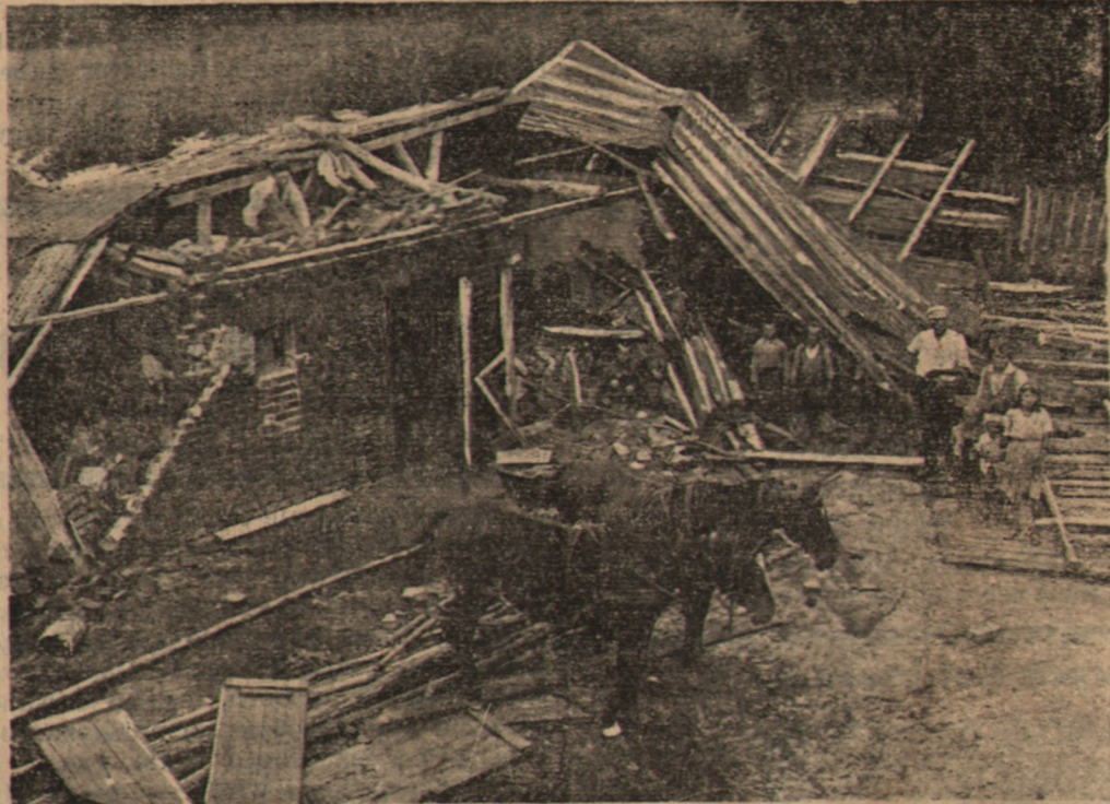
Huragan zniszczył doszczętnie dom mieszkalny w czasie gdy rodzina siedziała przy obiedzie
