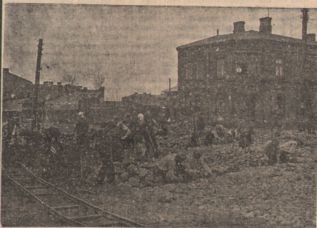
W całym kraju rozpoczęto szereg poważnych robót inwestycyjnych z kredytów Funduszu Pracy. Zdjęcie nasze przedstawia fragment tych robót przy brukowaniu rynku w Żyrardowie
