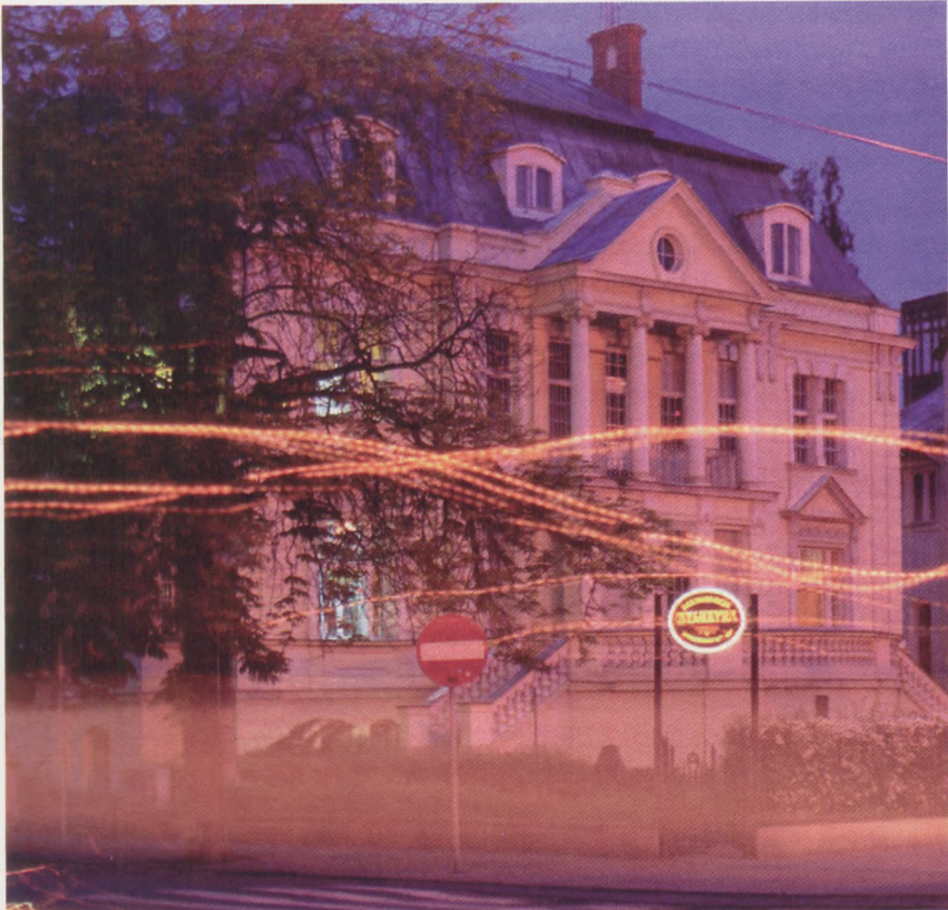
Budynek rozgłośni Polskiego Radia Pomorza i Kujaw
