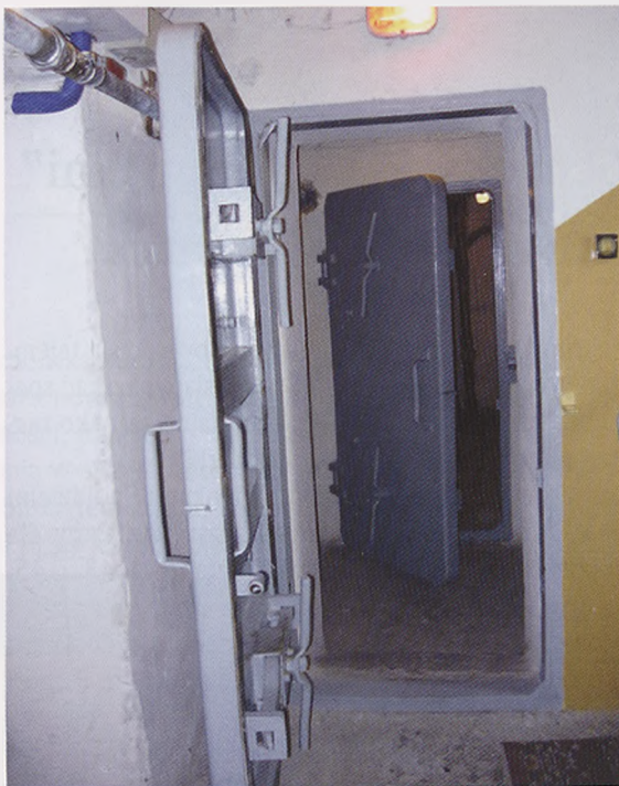
Przedśionek schronu przy ul. Lelewela 49 z ciężkimi drzwiami ze stalowej blachy
