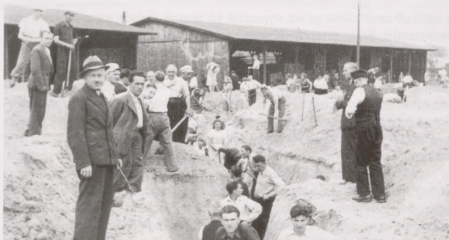
Budowa rowów przeciwlotniczych na zapleczu dworca Bydgoszcz Główna
