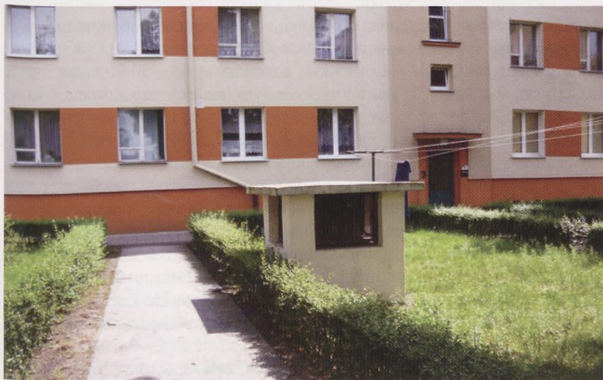
Szyb wyjścia zapasowego na zewnątrz budynku
