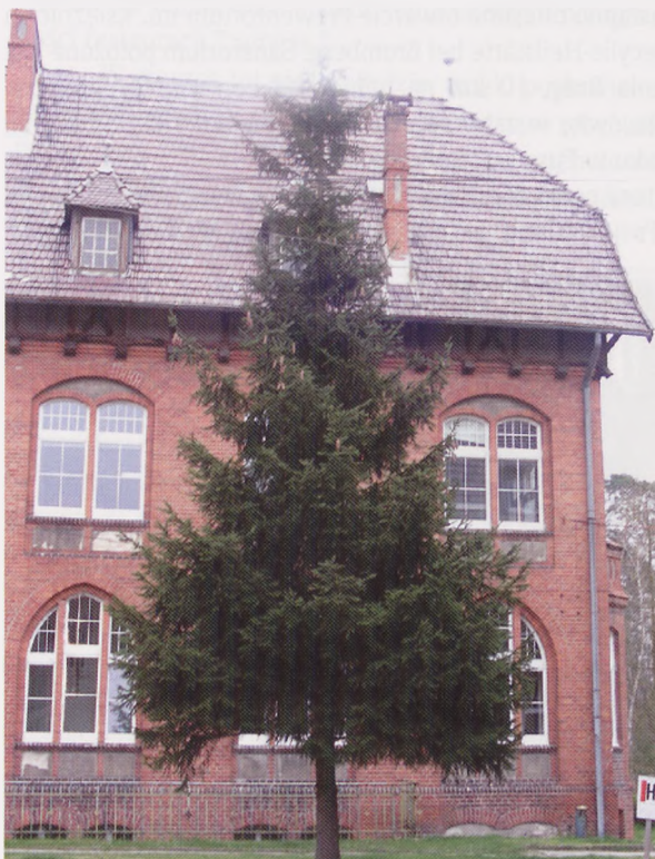
Budynek główny. Na parterze i w suterenie mieści się oddział rehabilitacji. Na wyższych kondygnacjach mieści się oddział leczenia gruźlicy i chorób płuc
