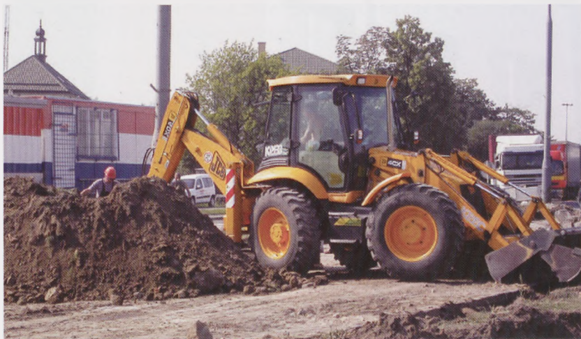
Roboty przy wymianie sieci ciepłej
