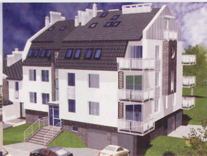
Budynek Z-4 ul. Łobżeńicka osiedle „Nad Brdą”
