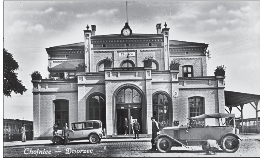
Ryc 118. Reprezentacyjny gmach dworca kolejowego widoczny od strony głównej w okresie międzywojennej.
