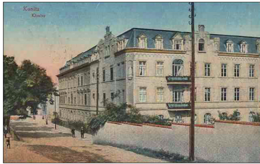
Ryc 74. Pocztówka chojnicka z widokiem na południową i wschodnią ścianę szpitala z początku XX w.
