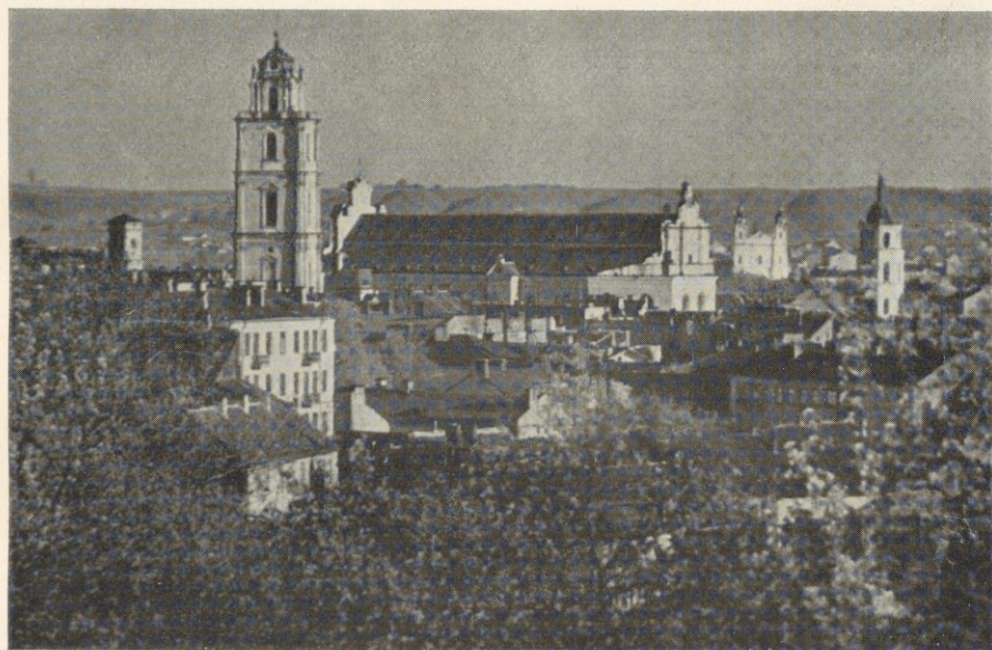
WIDOK Z OGRODÓW MISJONARSKICH
