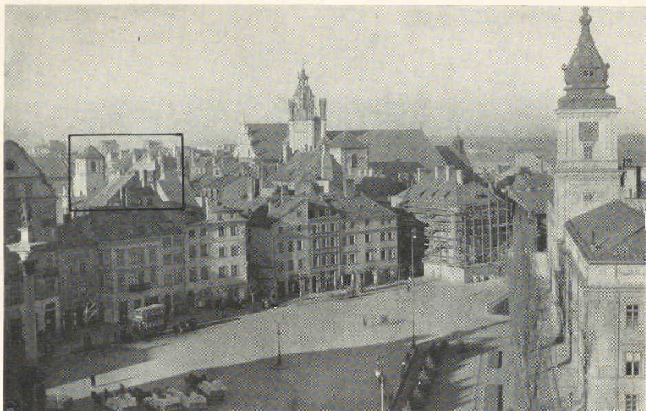
PLAC ZAMKOWY W WARSZAWIE Zdjęcie obiektywem o 18 cm ogniskowej
