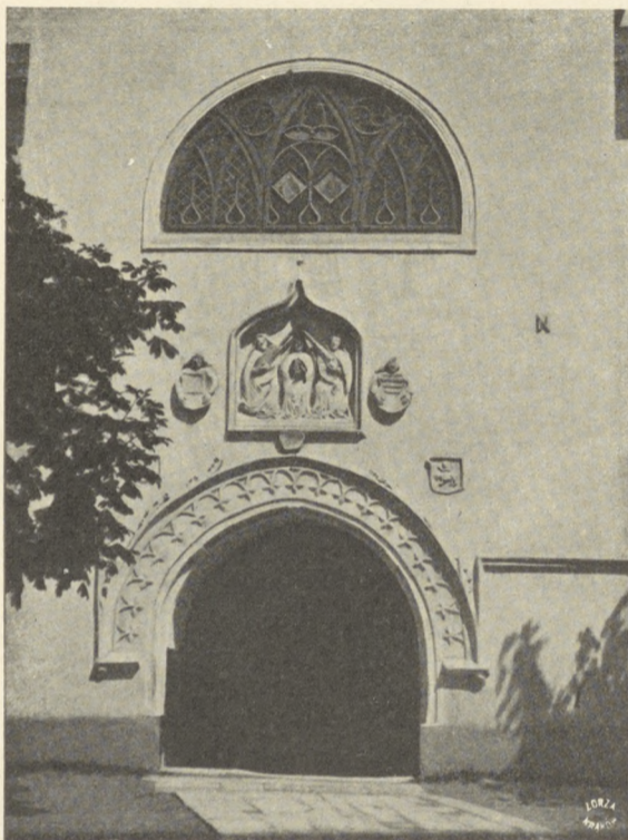
Fig. 30. Kraśnik, kościół, ściana kruchty południowej. Fot. p. Przegaliński.
