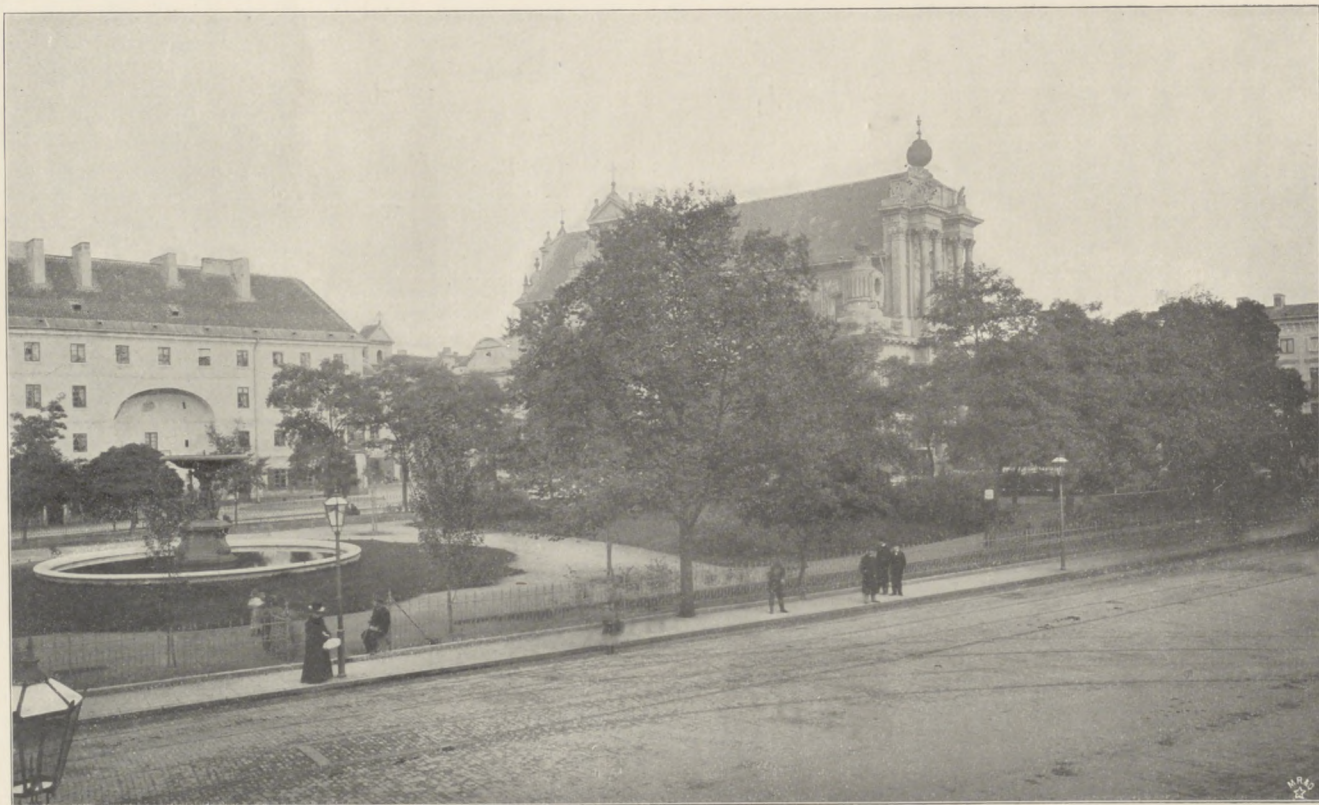
Widok dawnego skweru, na którym stanął pomnik
