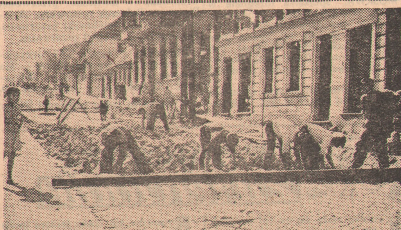
Jak już kilka dni temu podaliśmy, na ul. Kujarskiej od 10 sierpnia br. trwają prace nad poszerzeniem ulicy z 6,5 m na 10 m, oraz nad pokryciem jezdnii granitową kostką. 52 robotników, podzielonych na 5 brigad, do 15 listopada br. ma całkowicie przebudować ul. Kujarską aż do rytmu ul. Lwowskiej. — Na zdjęciu brigada robotników, układająca podłoże i kostkę — przy pracy. (Foto — IKP)
