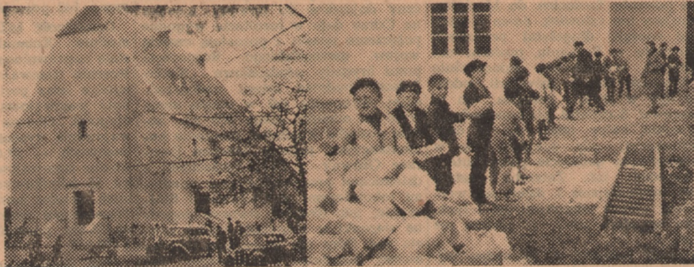
Z lewej: gmach nowej szkoły we Wtelnie. Z prawej: młodzież szkolna pomaga przy budowie. Foto — IKP
