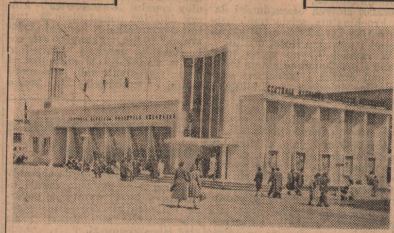
Pawilon Centrali Handlowej Przemysłu Drzewnego. (Foto: IKP)
