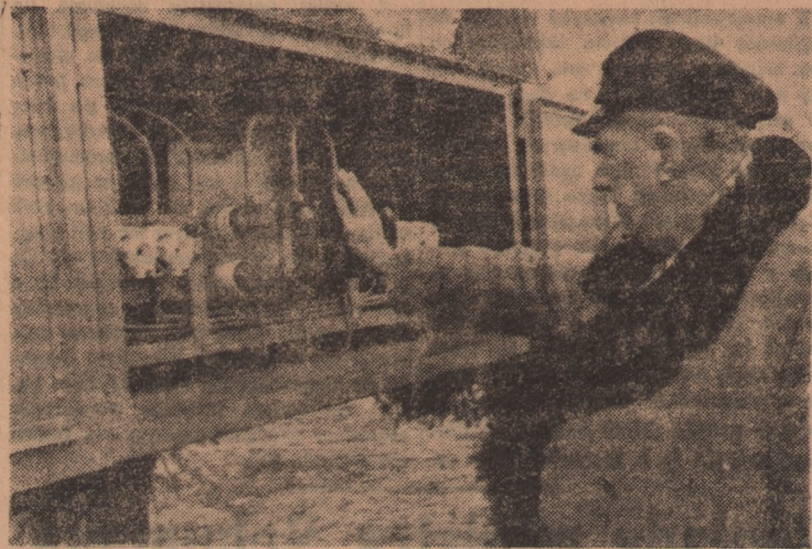
Wojewoda Kubecki wkręcił symboliczną żarówkę i nad udekorowanym transformatorem zablisyło światło...
